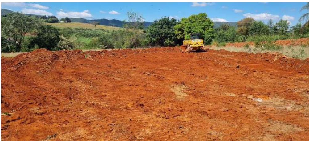
Foto 7 – Retirada dos entulhos dentro da área de plantio e direcionamento do material caminho de serviço. (Foto: 20/04/2023)
