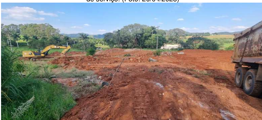
Foto 9 – Retirada dos entulhos dentro da área de plantio e direcionamento do material caminho de serviço. (Foto: 20/04/2023)
