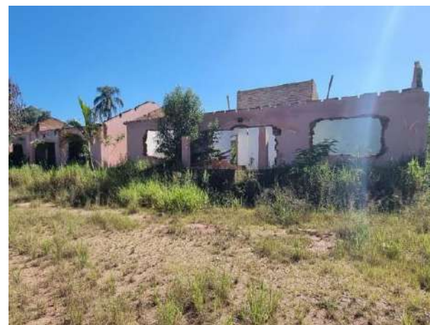
Foto 6 – Início da demolição estrutura 28H. (Foto: 31/03/2023)
