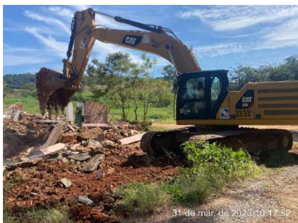
Foto 3 – Início da demolição estrutura 28. (Foto: 31/03/2023)
