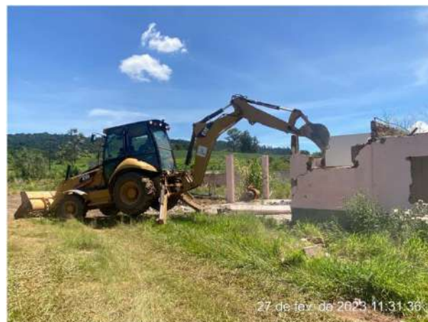
Foto 2 – Início da demolição estrutura 42H. (Foto: 27/02/2023)
