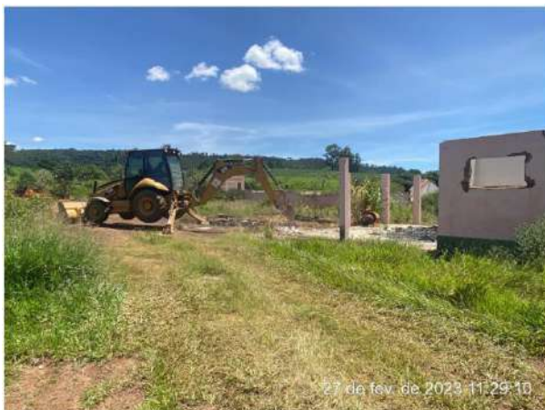
Foto 1 – Início da demolição estrutura 42 H. (Foto: 27/02/2023)
