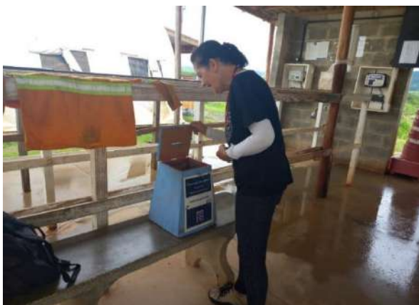
Foto 11 – Abertura da Caixa de Comunicação do Canteiro Duas Pontes (Data: 17/04/2023)
