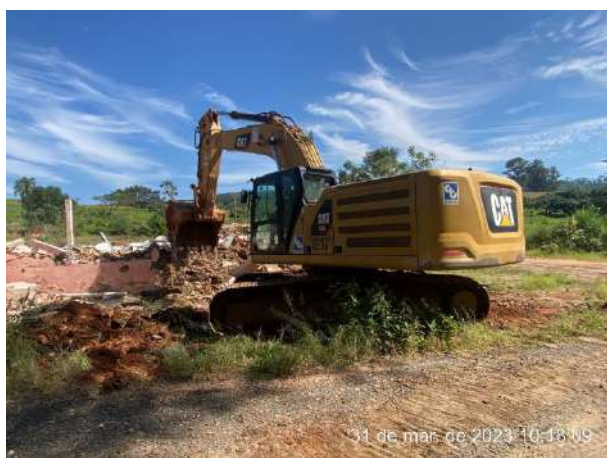
Foto 5 – Início da demolição estrutura 28. (Foto: 31/03/2023)
