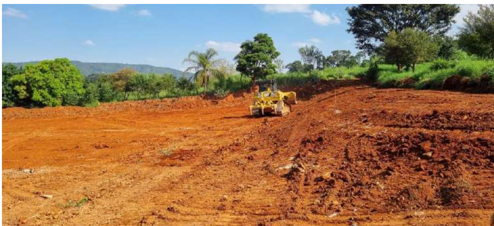
Foto 8 – Retirada dos entulhos dentro da área de plantio e direcionamento do material caminho de serviço. (Foto: 20/04/2023)
