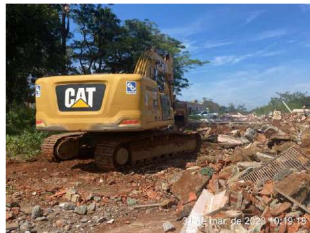
Foto 4 – Início da demolição estrutura 28H. (Foto: 31/03/2023)
